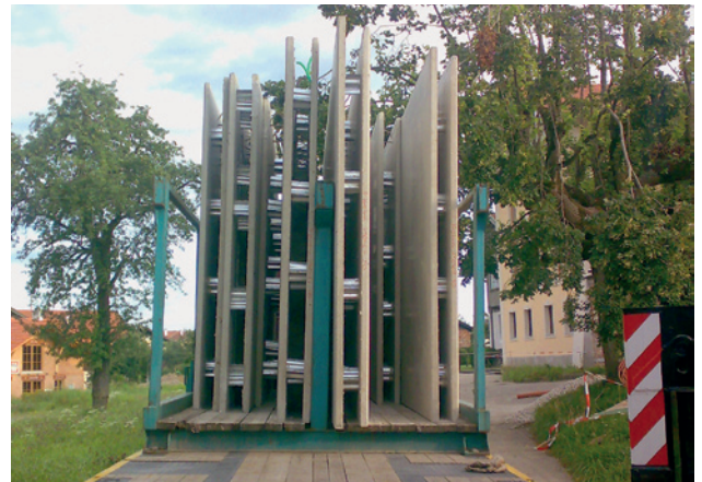
Dünne Schalen - weniger Transportgewicht Thin shells - less transport weight
