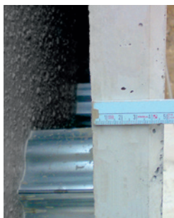
Schalenstärke 5 cm Shell strength 5 cm
