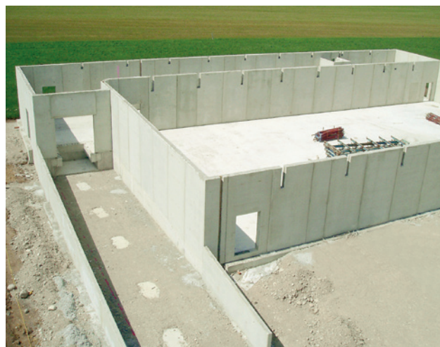
Baustelle Lidl-Markt Building site Lidl-Markt
