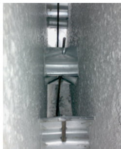
Anschlußbewehrung durchdringt die KAP-STAH-LWELLE Starter bars penetrate the KAP-STEEL-WAVE
