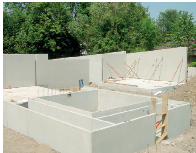
Baustelle Kormann Building site Kormann
